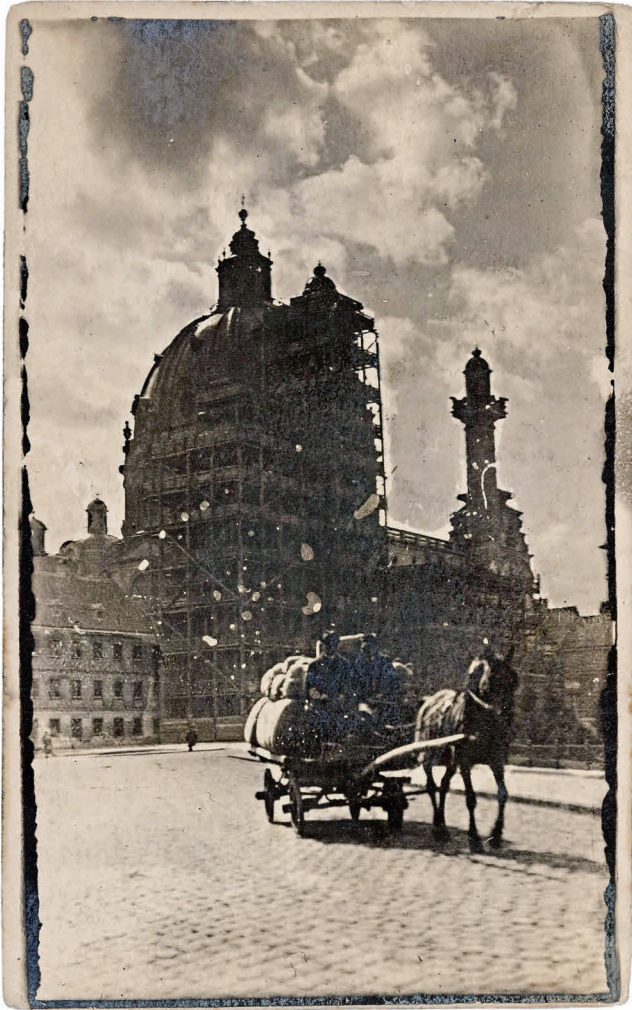
Abb. 2: Gesamtansicht der eingerüsteten Kirche, Ansichtskarte von 1909
