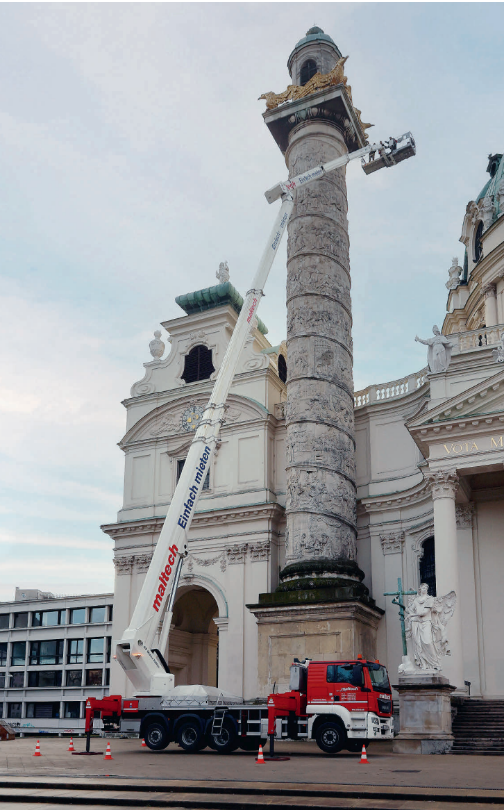
Abb. 1: Karlskirche, östliche Triumphsäule: Befahrung Februar 2023
